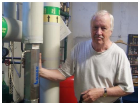
Kennet är en nöjd kund som gärna rekommenderar Bauer Pipejet och Energi & Driftteknik som gjorde ett snabbt och bra installationsjobb.
